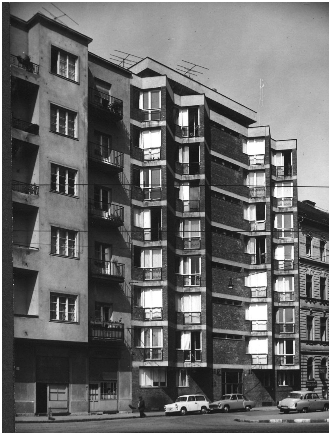
16.kép Budapest. Hajnóczy utca 4. OTP lakóház 24 lakás, Építészek: Tokár György, Emődy Attila. MIEA 8269, MÉ 1965/3
